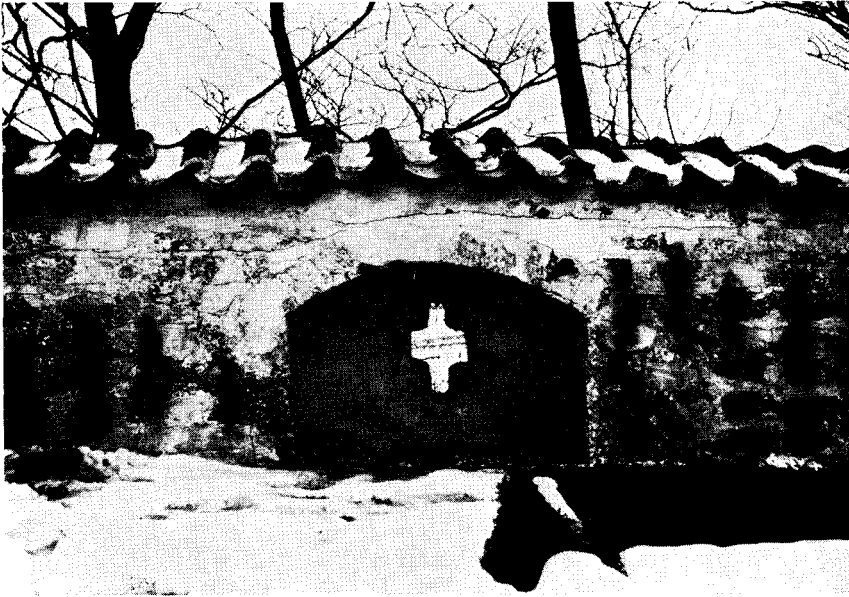
Fig. 11. Et af de ca. 13 bevarede skydeskår i kirkegårdsmuren i Kundby (Holbæk amt). Nogle af de 13 huller er for nylig ved anlæggelsen af en toilet-bygning blevet muret til på indersiden. Da skydeskårene er anbragt ganske lavt, har man åbenbart måttet knæle ell. ligge ned under et forsvar. J.L. fot. 1969.
