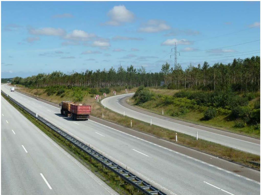
Tilslutningsanlæg med markant beplantning af yngre birketræer. Foto: Marianne Ujvári.
